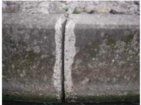
図 3.4-9 目地材なし（板材系目地の腐食）
