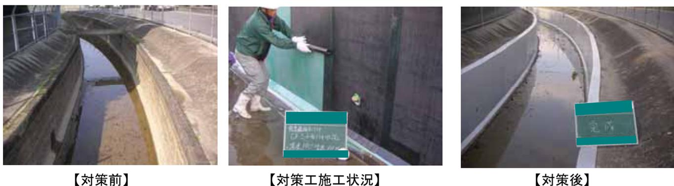
図 5.3-7 炭素繊維シートの接着による開水路の補強事例
