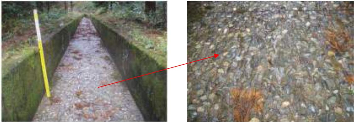
図 3.3-4 急流工に生じた物理的作用による摩耗
