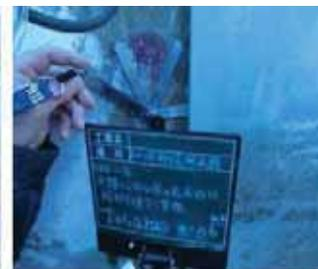
パネルと充填材の隙間最大0.6mm(パネル端部)
