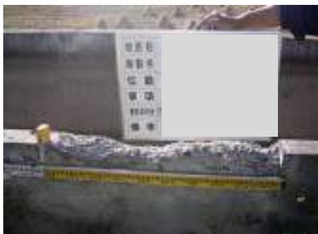
図 3.3-8 側壁天端に生じたスケーリング
