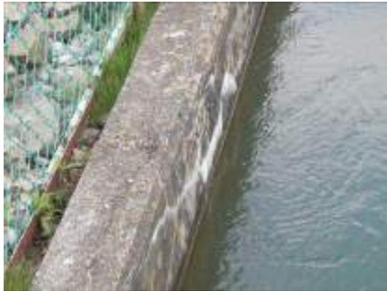
図 3.3-14 アルカリシリカ反応による亀甲状のひび割れとゲルのしみ出し
