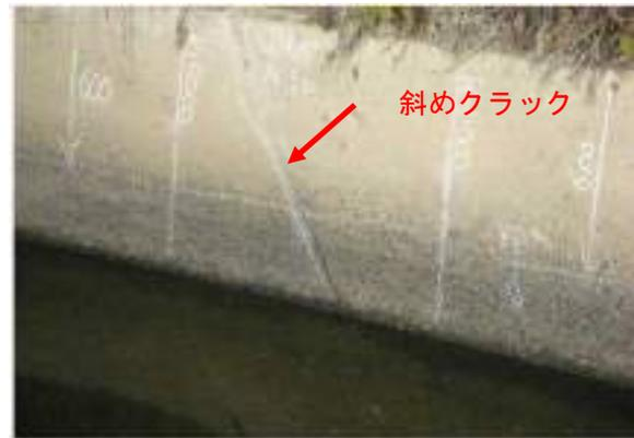
図 3. 4-6 開水路に生じた外力によるひび割れ
