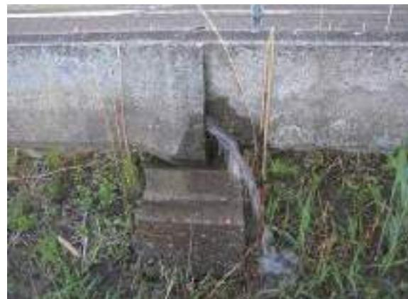
図 3. 4-2 不同沈下による目地からの漏水
