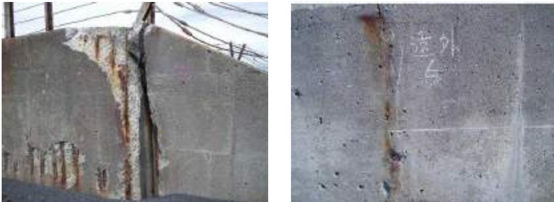
図 3.3-37 塩害による変状
