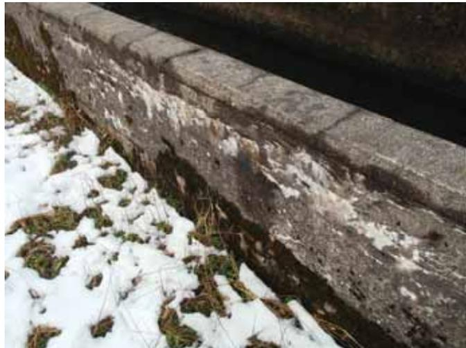
側壁上部の「凍害によるひび割れとスケーリング」
