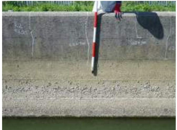
図 3. 2-1 乾燥収縮ひび割れの発生イメージ
