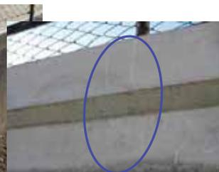
断面修復やひび割れ補修を行った上に表面被覆をした箇所に浮き等の変状が発生しやすい。断面修復等の施工箇所を確認しておく。
