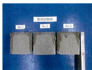
無塗布 (原状試験体)
