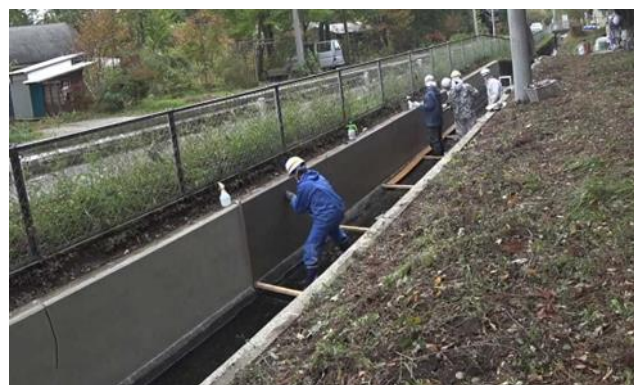
写真 16 開水路補修状況（北関東地方）
