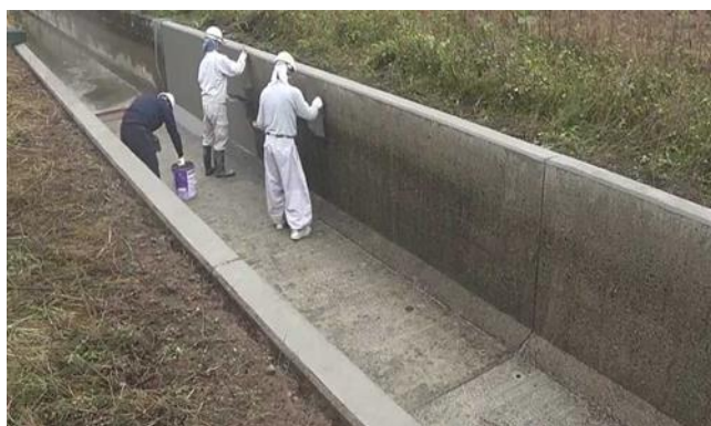
写真 15 開水路補修状況（北陸地方）
