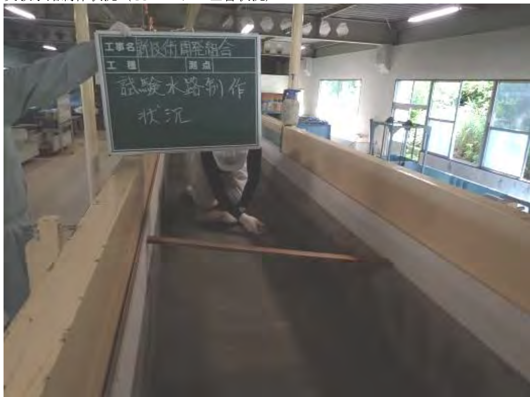
実験水路制作状況（CSモルタル左官状況）
