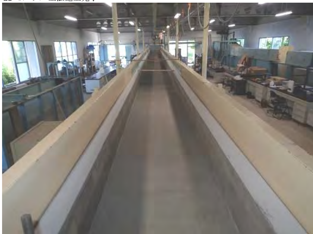
CSモルタル工法施工完了
