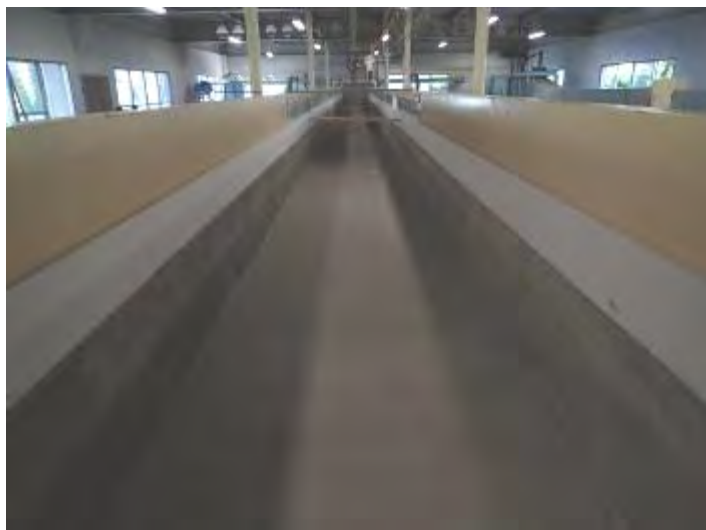
写真 2 CS モルタル工法施工後の実験水路内面
