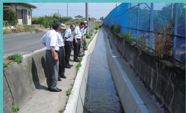
施工現場視察状況
