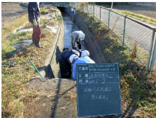
写真 4.3.1-1 水路底版の清掃
