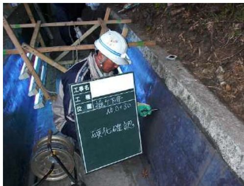
写真 5. 4. 3-4 硬化確認状況
