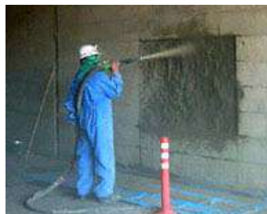
写真 7.1.2-2 吹付け工法
