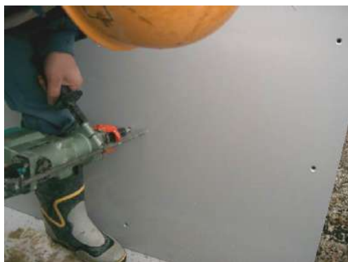
写真 5. 3. 3. 2-1 アンカー打設用下穴削孔
