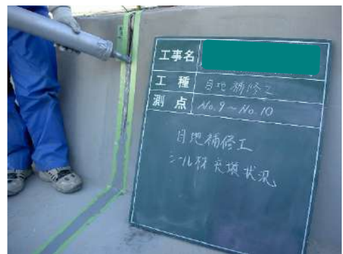
写真 8.3.1-1 シーリング材の充填
