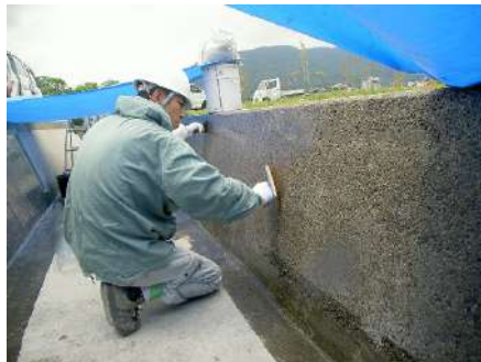
写真 5. 4. 3-2 ヘラによるプライマーの塗布状況
