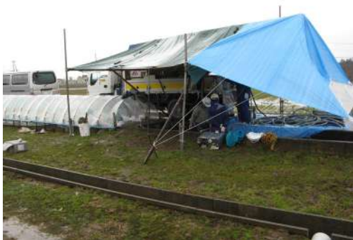
写真 5. 2. 4-1 ビニールシート養生設置
