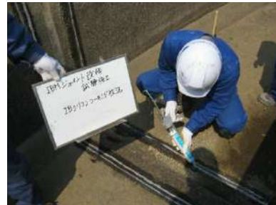
写真 8.3.2-6 シーリング材打設
