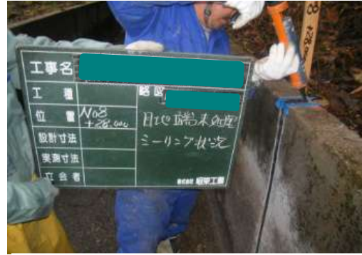
写真 8. 3. 2-15 端部処理
