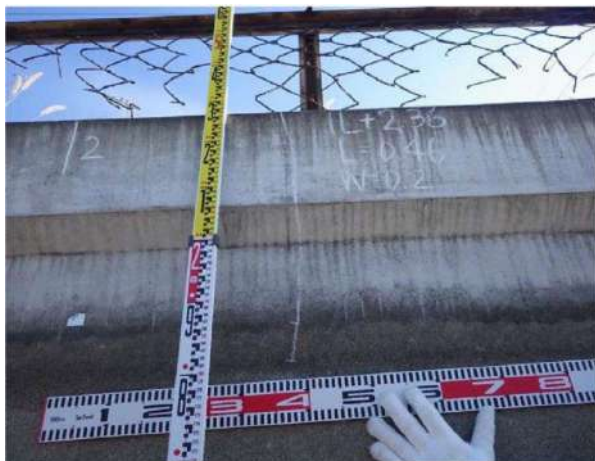
写真 5.1.4.1-1 乾燥収縮ひび割れ（モニタリング調査事例）
