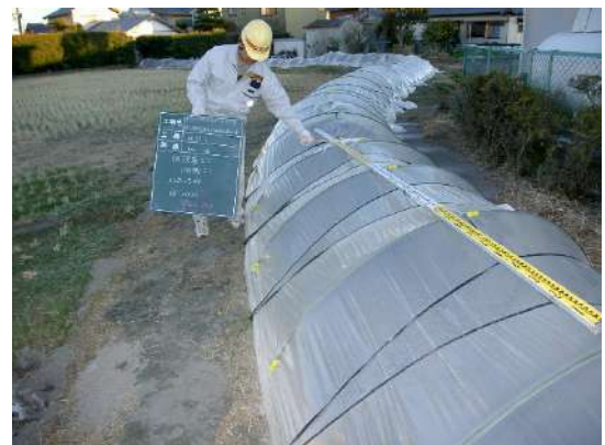
写真 4.3.1-2 養生工の設置
