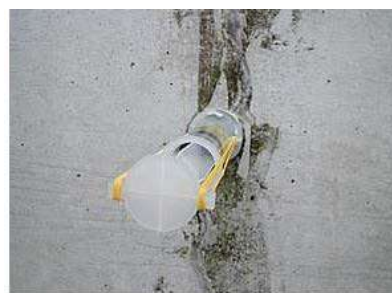
写真 6.3.1-3 注入用器具による注入例
