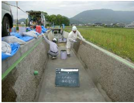
写真 5. 4. 3-1 ローラーによるプライマーの塗布状況
