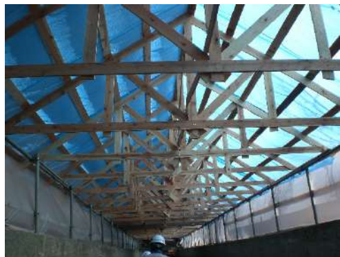
写真 5. 2. 4-2 ビニールシート養生設置内部
