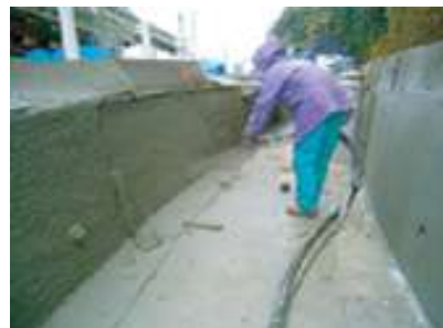
写真 5.1.1-2 無機系被覆工法（吹付け工法）施工状況
