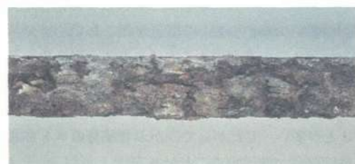
腐食度区分：D 又は IV
