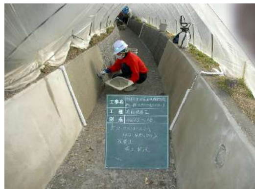
写真 5. 1. 3-6 左官コテによる施工
