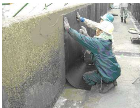
写真 5. 4. 3-7 シートの貼付け状況
