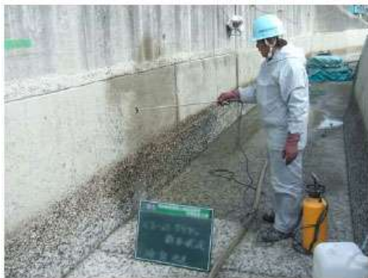
写真9.3-1 表面含浸材塗布（噴霧）
