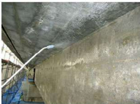
写真9.3-4 表面含浸材塗布（噴霧）
