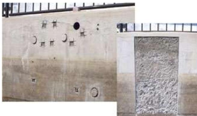
図 11. 5. 2-4 【はつり調査状況】
