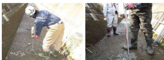
写真 2.3-1 底版ドリル削孔による空洞高さの確認
