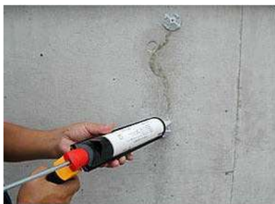
写真 6.3.1-2 注入用座金の設置と ひび割れ表面のシーリング状況
