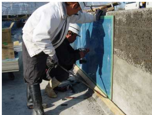
写真 5.3.2.2-2 パネル設置工
