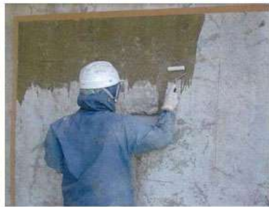
写真9.3-5 表面含浸材塗布（ローラー）
