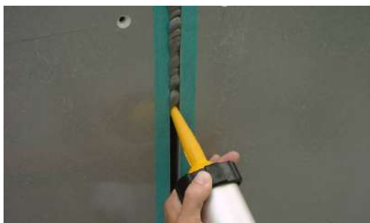
写真 5. 3. 3. 2-3 パネル目地工
