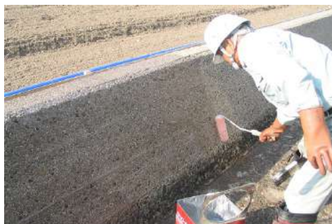
写真 5.1.3-4 プライマー塗布
