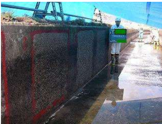
写真 4. 3. 2-3 試験状況(下地処理完了)
