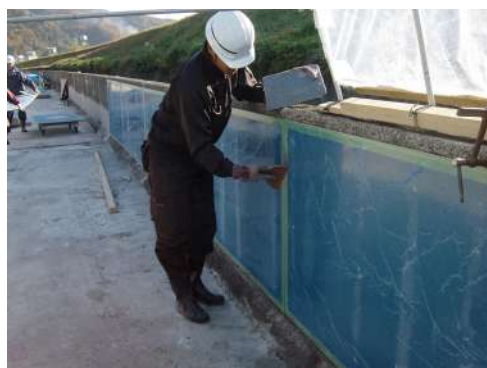
写真 5.3.2.2-3 パネル目地工
