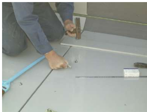
写真 5. 3. 3. 2-2 アンカー打設によるパネル取付工
