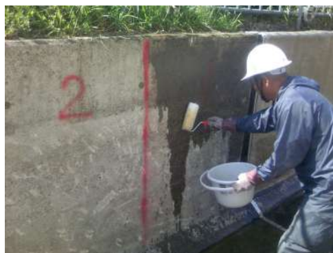
写真 5.3.2.2-1 プライマー工
