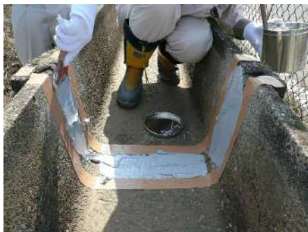
写真 8.3.2-1 接着材の塗布
