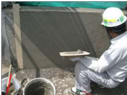
写真 5.1.1-1 無機系被覆工法（左官工法）施工状況
