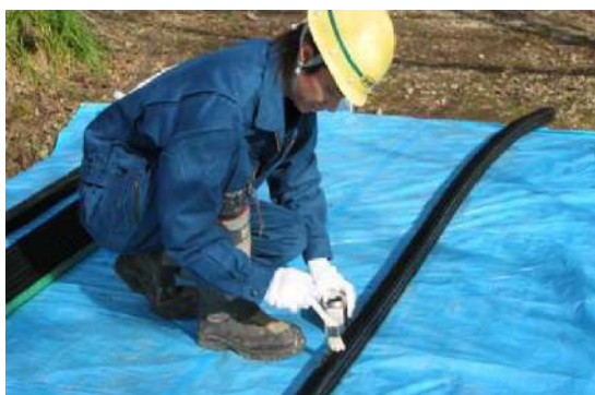
写真 8. 3. 2-12 接着材の塗布状況(1)
