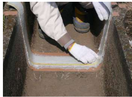
写真 8.3.2-2 シートの貼り付け
