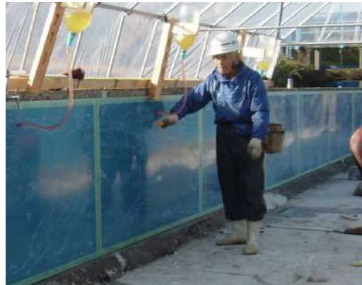
写真 5.3.2.2-4 樹脂注入工
