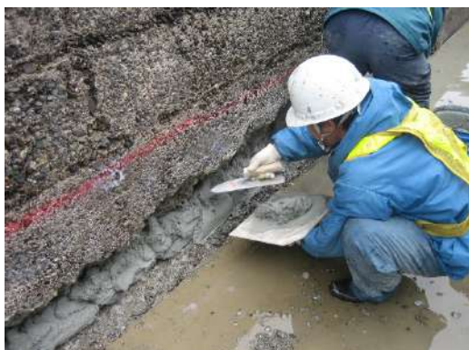
写真 5.1.3-1 断面修復材の充填
