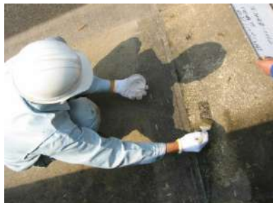
写真 8.3.2-5 プライマー塗布
