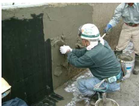
写真 5. 4. 3-6 ポリマーセメントの塗布状況
