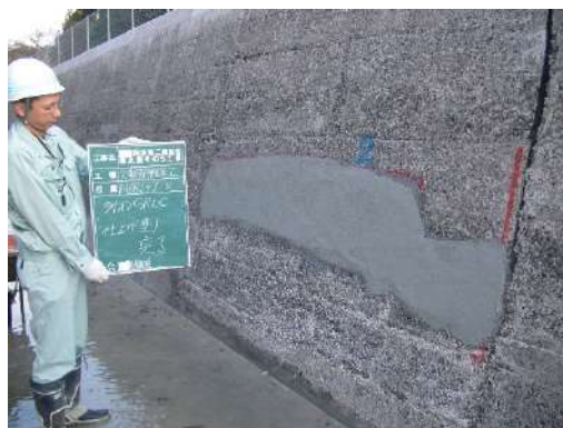
写真 5.1.3-2 断面修復終了後
