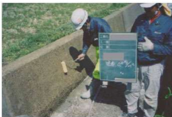
写真9.3-2 表面含浸材塗布（ローラー）
