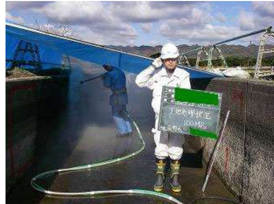
写真 4. 3. 2-2 試験状況(下地処理)
