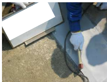
写真 8.3.2-8 シート取付け アンカー打設
