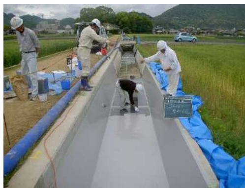
写真 5. 4. 3-5 トップコート塗布状況
