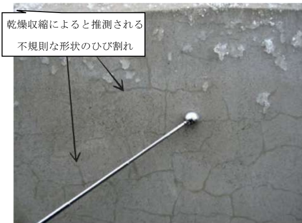
写真 5.1.4.1-2 乾燥収縮ひび割れ 4)
