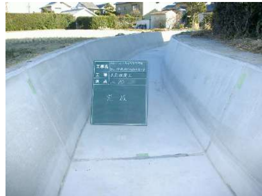
写真 5. 1. 3-9 表面被覆完了
