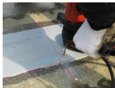
写真 8.3.2-7 シート取付け アンカー削孔
