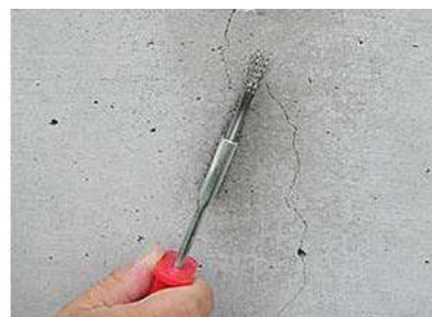
写真 6.3.1-1 ひび割れ部の清掃の例
