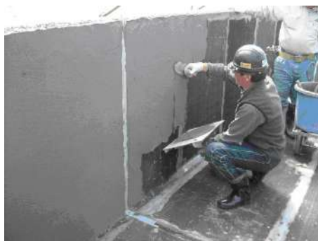
写真 5. 4. 3-8 保護モルタルの左官仕上げ状況
