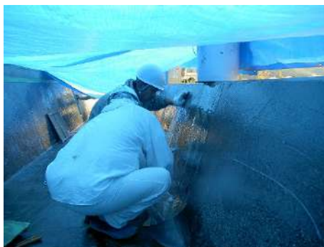
写真 5. 4. 3-3 脱泡作業状況
