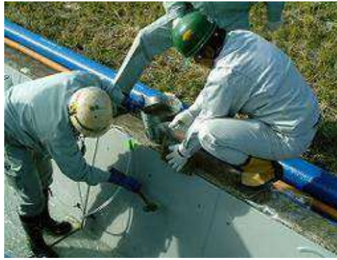
写真 5.3.3.2-4 グラウト注入工（ポンプ圧入の場合）
