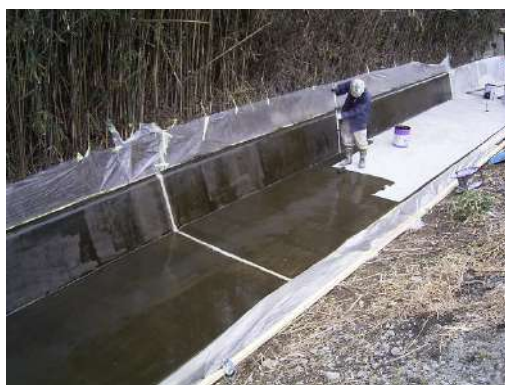
写真 5. 2. 4-4 プライマー工
