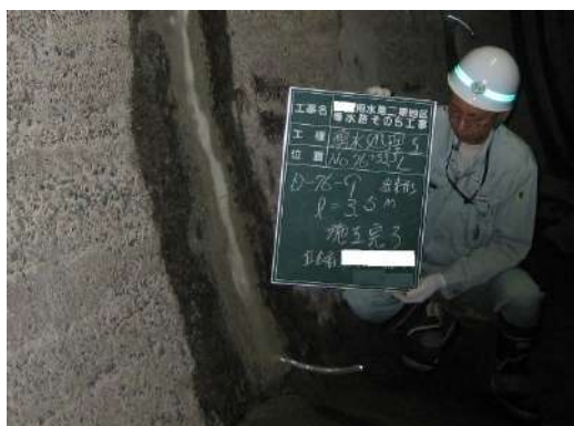
写真 5.1.3-3 ひび割れからの湧水の導水処理
