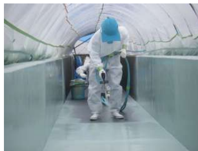
写真 5.2.1-2 有機系被覆工法 （吹付け型）施工状況
