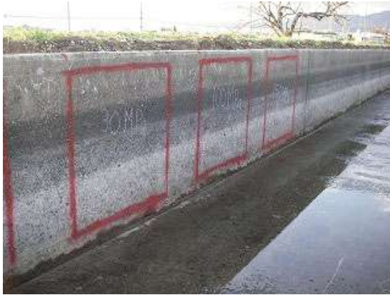
写真 4. 3. 2-1 現場試験施工前
