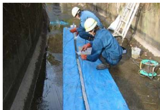
写真 8. 3. 2-13 接着材の塗布状況(2)
