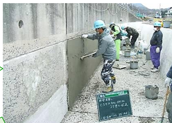
④：CSモルタルコテ塗り
