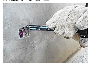
被覆厚さ測定（硬化後）
