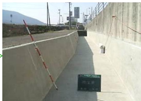
⑥：施工完了
