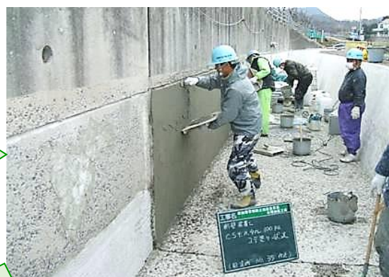
④：CSモルタルコテ塗り
