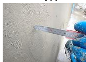
被覆厚さ測定（硬化前）
