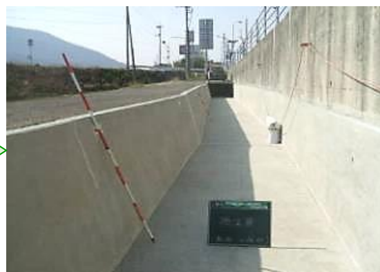
⑥：施工完了
