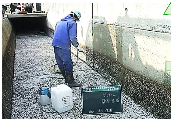
③：CSクリアー（1回目-躯体面）
