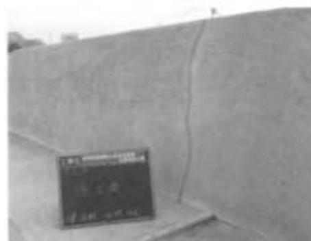
写真-6 施工完了 ひび割れ部
