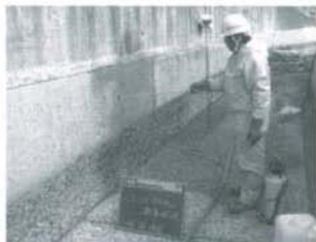
写真-1 コンクリート改質剤散布状況
